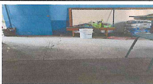
FOTO 2 : SUSTITUCIÓN DE PISO CERAMICO
