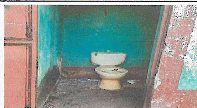
FOTO 4: SUSTITUCIÓN DE INODOROS
