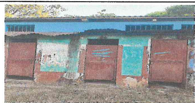
FOTO 5. SUSTITUCION DE LAMINA POR LAMNA TROQUELADA
