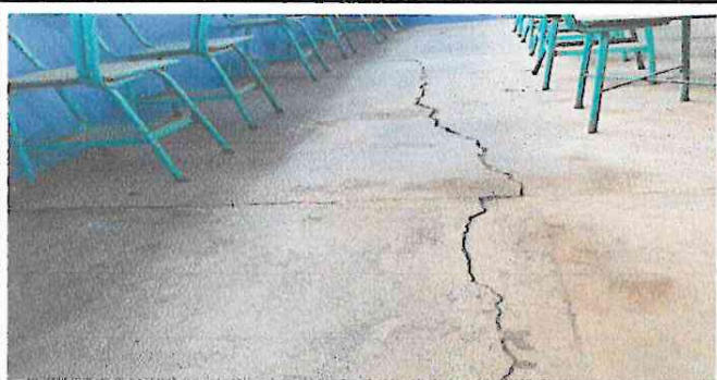
FOTO 1 : SUSTITUCIÓN DE PISO CERAMICO
